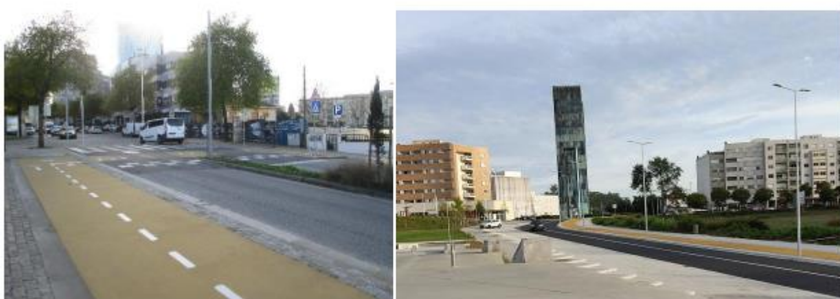
Figura 4. Ciclovias existentes - Avenida D. Manuel II e Avenida de Altino Coelho
