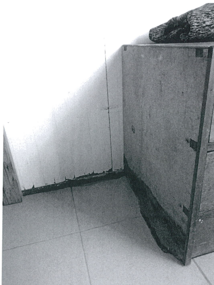
9 - Degradação de paredes e de móveis por efeito da humidade
