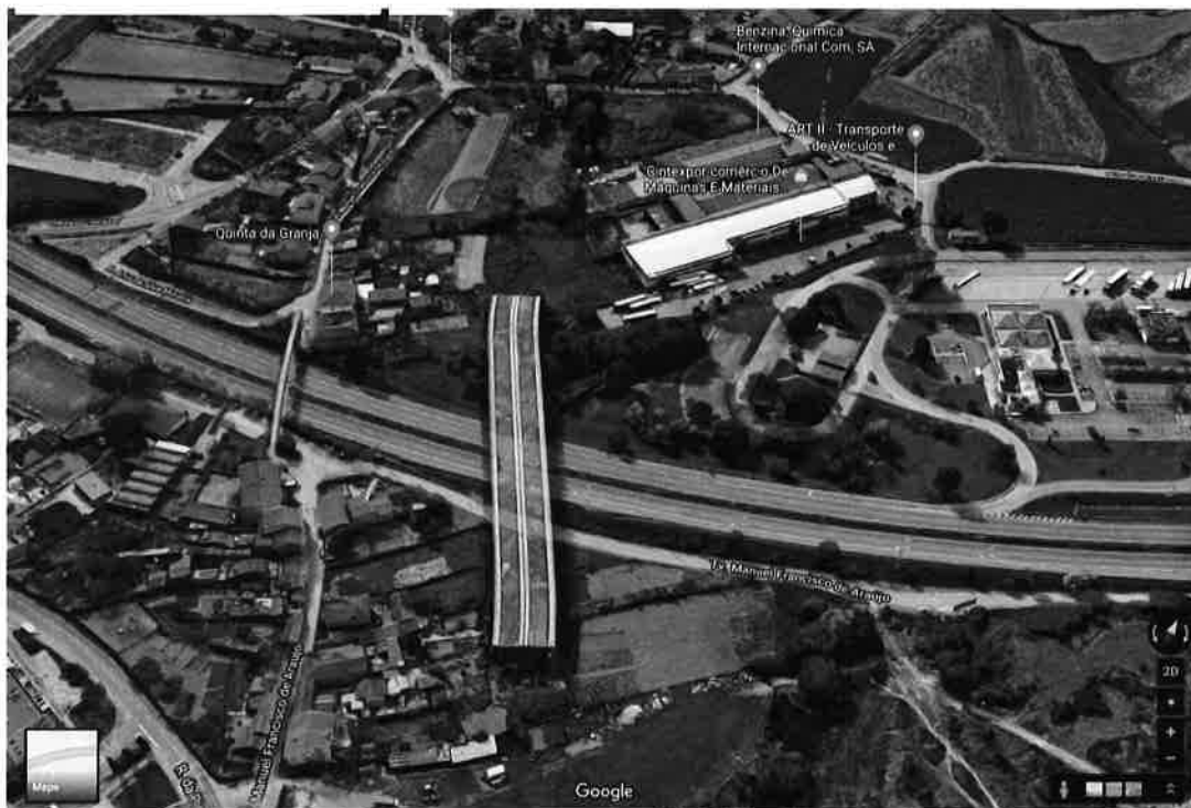
1 – Aspecto do viaduto “órfão” sobre a A4 na Quinta da Granja
