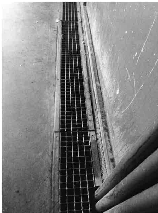
6 - escoamento e drenagem de águas pluviais ao longo dos contentores no alçado para o logradouro
